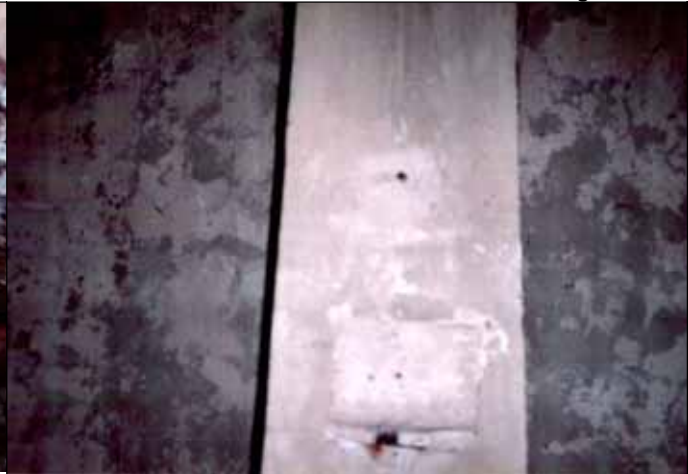
Dokument 12: Leichenhalle im Krematorium I von Auschwitz. Einer der in der Mitte des Stützbalkens der Decke eingelassenen Holzblöcke. Oktober 1991. © Carlo Mattogno.
