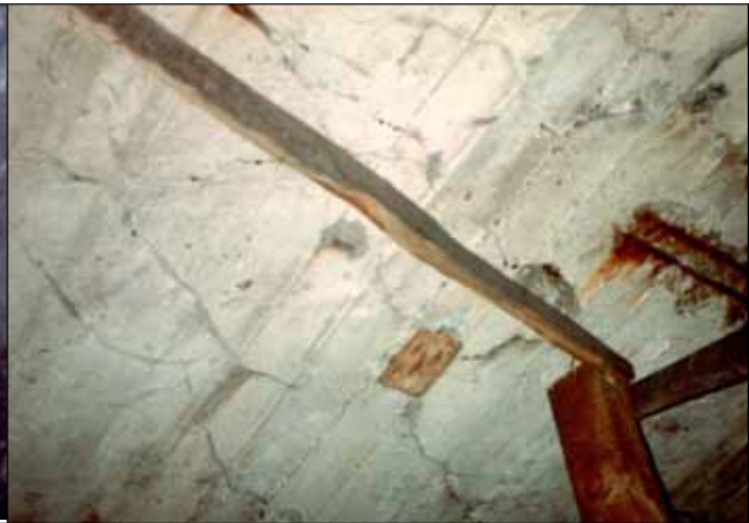
Dokument 10: Weiterer Befestigungsblock für Lampen in der Decke von Leichenkeller 1 im Krematorium II von Birkenau. Oktober 1991. © Carlo Mattogno.
