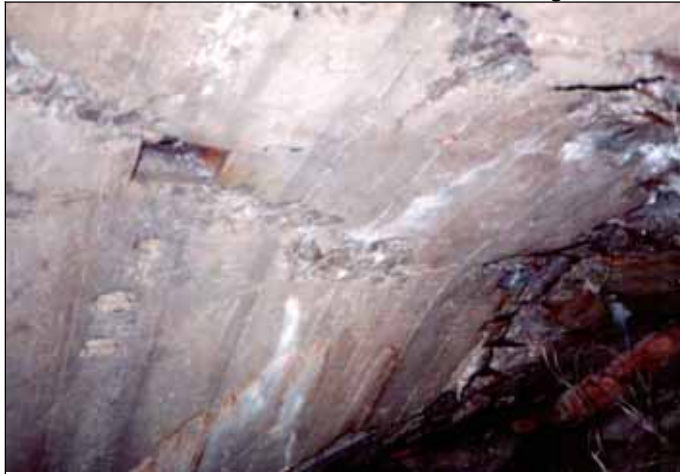
Dokument 11: Aussparung im Beton der Decke von Leichenkeller 1 im Krematorium II von Birkenau für einen Befestigungsblock für Lampen zur Raumbelichtung. Juli 1992. © Carlo Mattogno.
