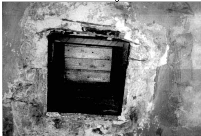
Dokument 13: Fotografie der Decke der Leichenhalle. Einer der vier von den Polen gebauten Schächte. © Carlo Mattogno.
